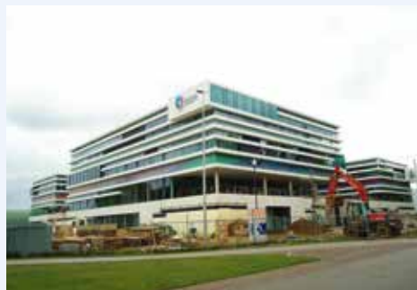
Nieuwbouw DSM AHEAD
